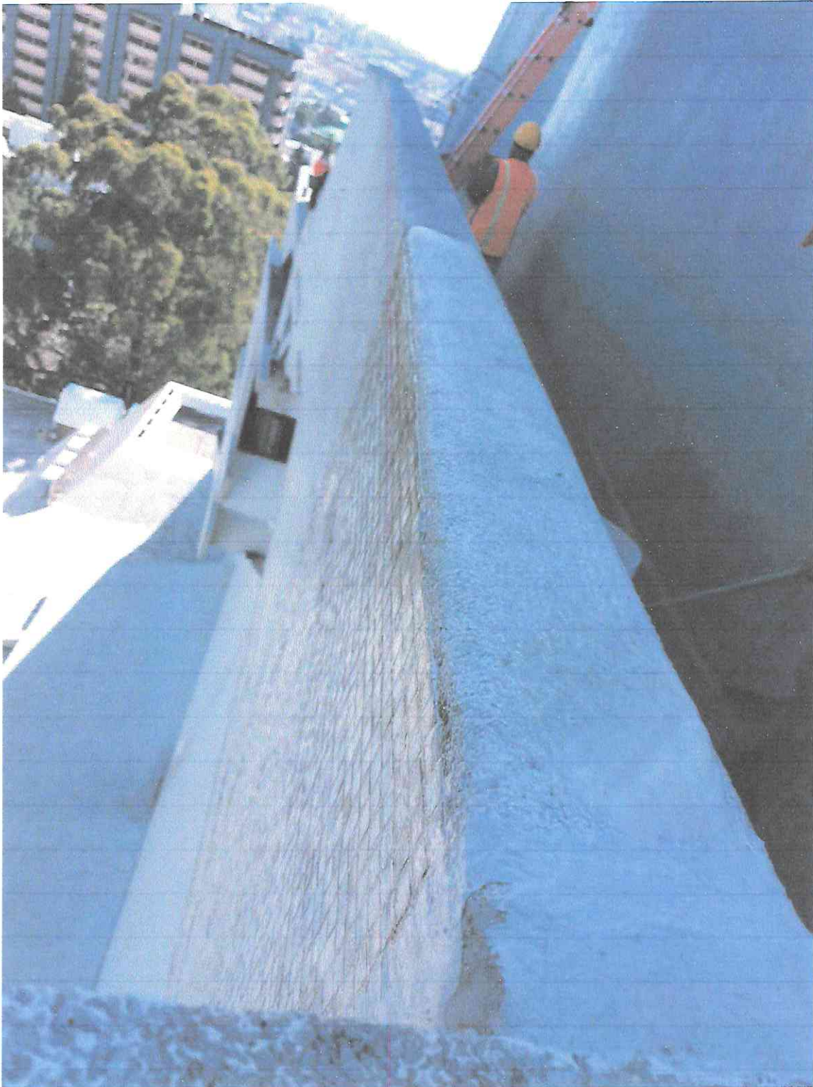
Limpieza de bordillo de granito y teselas en segmento A1 de la fachada Oriente.
